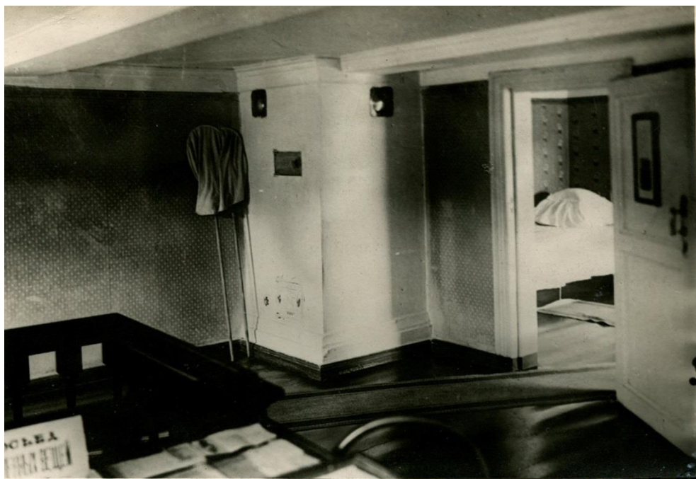
Фото 7. Потолочная деревянная балка опирается на двухъярусную печь в детской комнате
